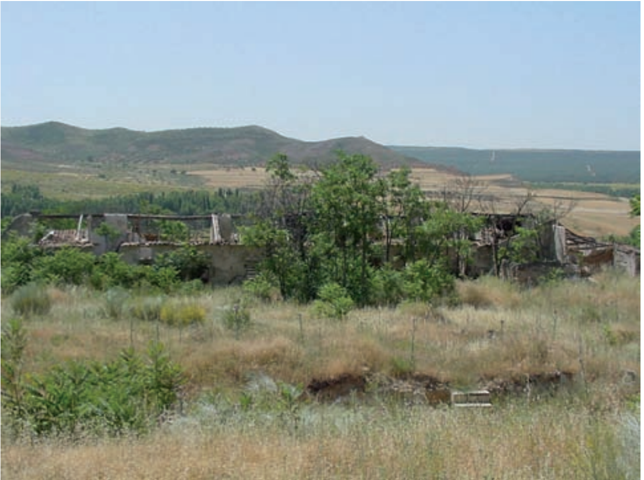
Ruinas que se conservan de la Caserna
