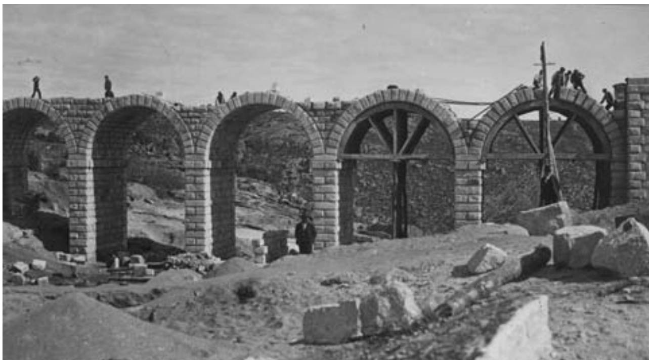
Construcción del puente-acueducto de La Alameda sobre el canal Transversal
