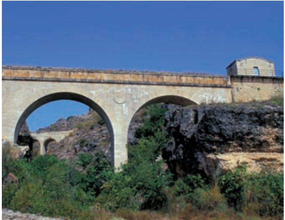
Ruinas del Hospital junto a la Ermita. Acueducto de Las Cuevas
