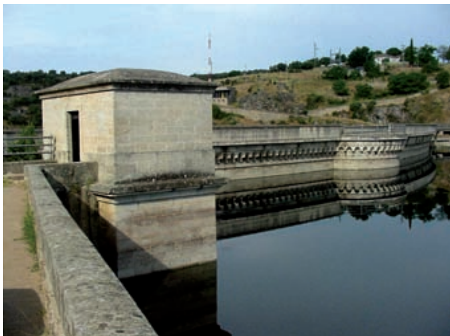
Almenara que regula la toma de la presa y panorama de El Villar aguas arriba
