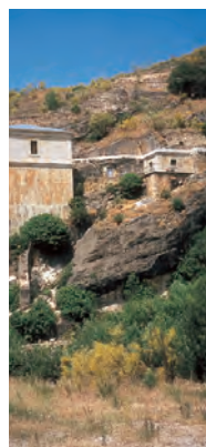
Lajas de oscura pizarra de tono rojizo forman los muros de las viviendas
