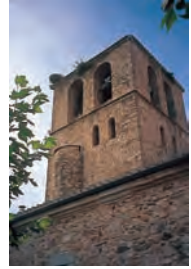
La torre de la iglesia conserva parte de su antigua estructura defensiva medieval
