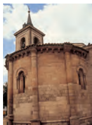
Ábside románico de la iglesia parroquial, ejemplo excepcional en la Comunidad de Madrid
