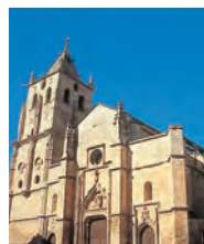
La torre cuenta con tres cuerpo con contrafuertes rematados por pináculos
