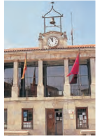
Fachada principal del ayuntamiento de Robledo de Chavela
