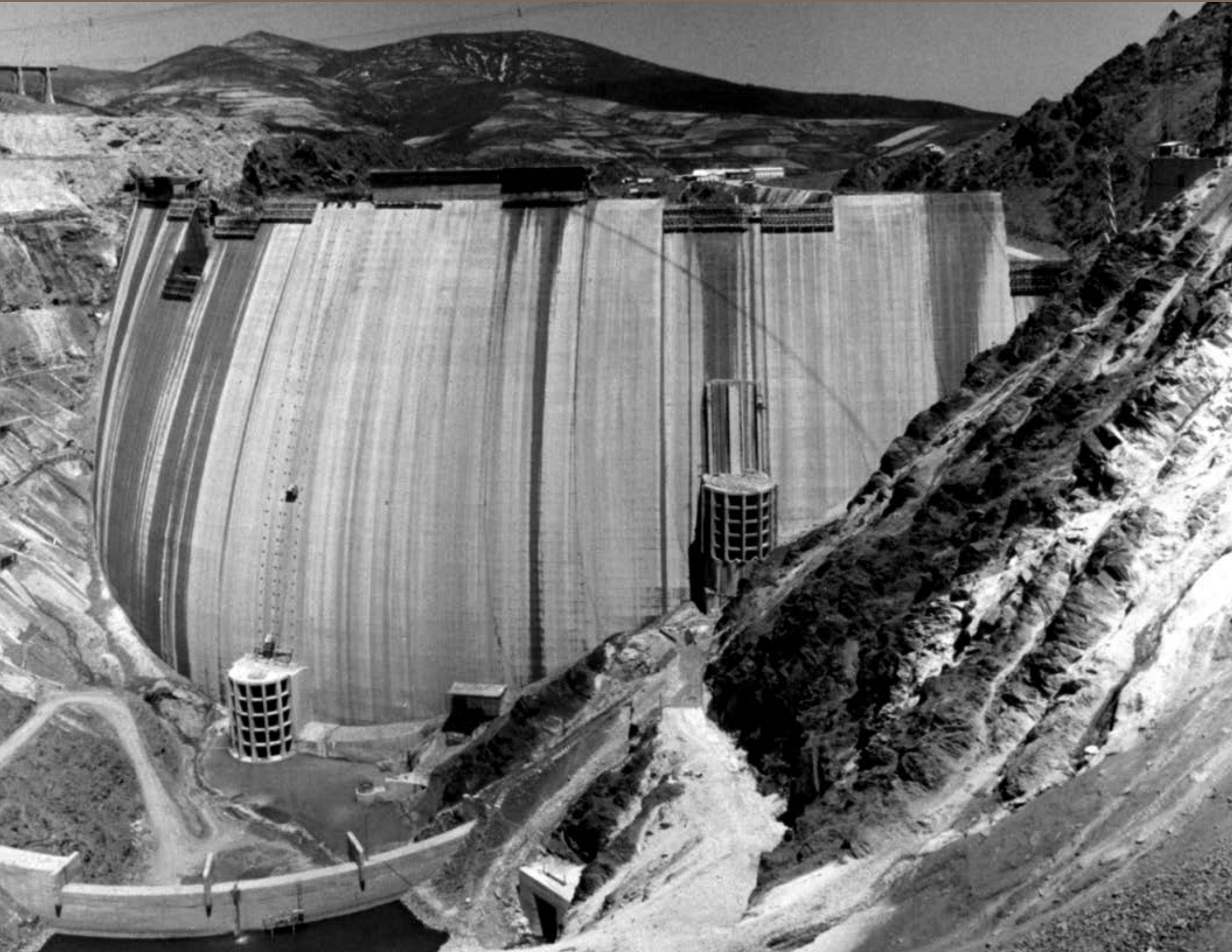
< Construcción de la presa de El Atazar
